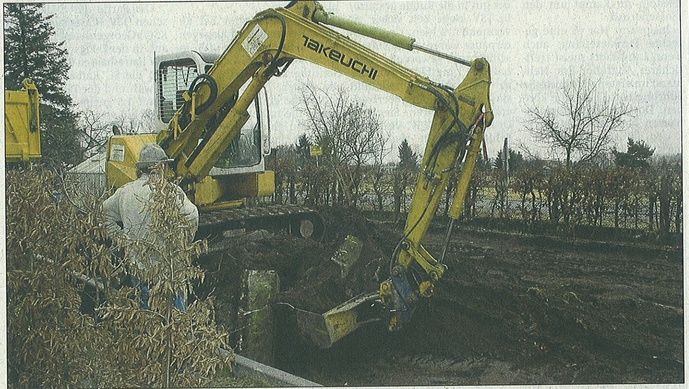
Mit schwerem Gerät war die Firma Aumann im ehemaligen Lehrergarten an der Alten Schule im Einsatz. Allein 20 Ladungen Oberboden wurden abgefahren. Foto: Petra Grimm
