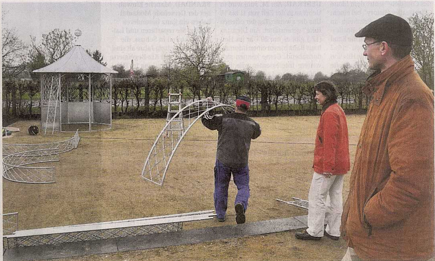
Ein Pavillon wurde jetzt im neuen Sinnengarten in Hergershausen installiert. Bis zur Eröffnung wird es aber noch ein wenig dauern, da noch einige Arbeiten anstehen.
